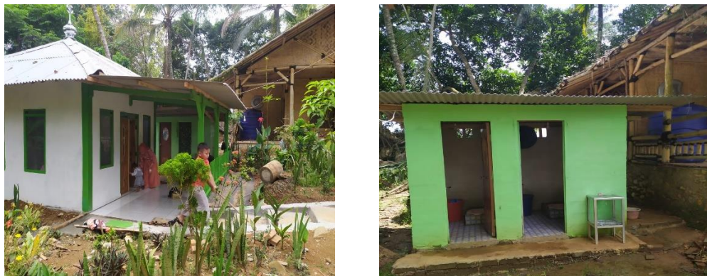
Gambar 3. Kondisi mushola dan toilet
